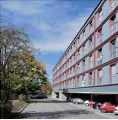
so konnten die Bauprozesse in Anlehnung an Industrieprozesse optimiert werden. Die Fassade ist anders als Decken und Wände, die aus Brettsperrholz bestehen, als Holzrahmenkonstruktion mit 20 cm Stärke ausgeführt. Zwischen das Rahmenwerk wurde Mineralwolle als Dämmung eingelegt. Das Rahmenwerk erhält beidseitig eine zweilagige Brandschutzbeplankung aus Gipsfaserplatten. Innenseitig ist keine Installationsebene vorgesehen.
